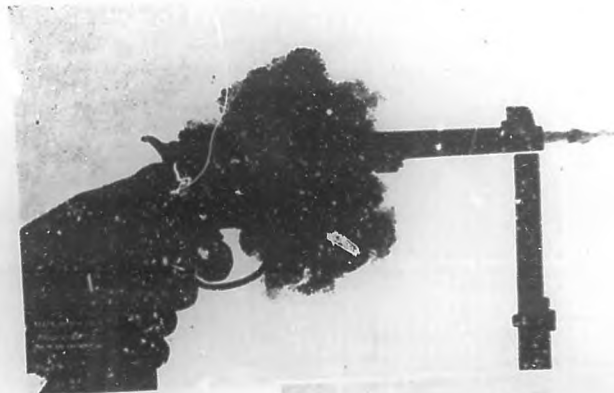
LA BALA A PULGADA Y MEDIA DEL CAÑON. —Esta foto muestra la bala a pulgada y media aproximadamente de la boca del cañón, y en este instante la elevación del cañón era de 0.99 de pulgada. En la foto anterior puede verse que la elevación del cañón en el momento de salir la bala era de 0.06, lo cual corresponde a una desviación del blanco de 4 pulgadas hacia arriba, en una distancia de 20 pies, y no 15 o 20 pulgadas como generalmente se creía.
