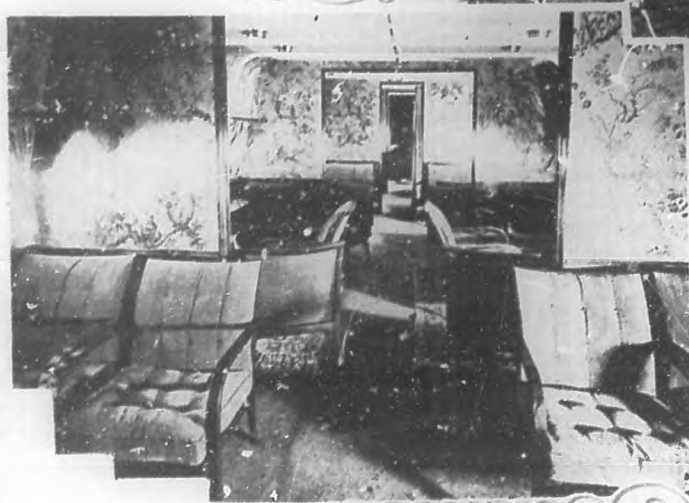
Un aspecto del salón interior del "Do-X".
